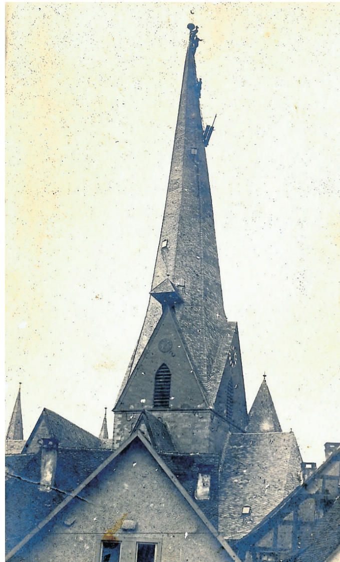
1906: Ausbesserungsarbeiten am Turm – ohne Gerüst, aber mit Seil.
